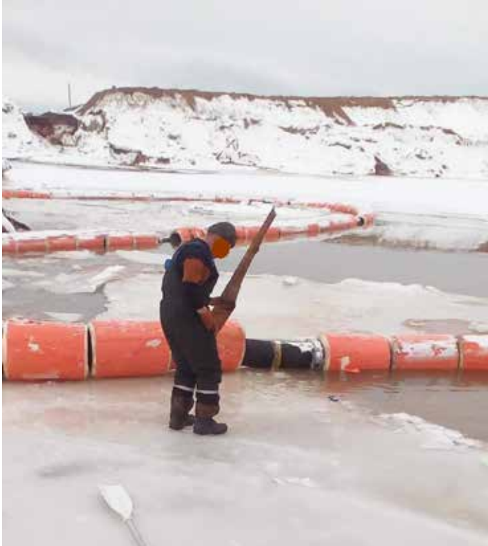
Рис. 1. Грубое нарушение техники безопасности при работе на льду
