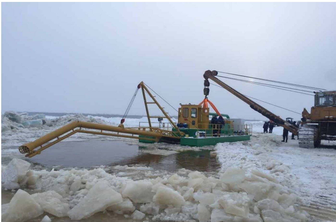
Рис. 3. Работа грузоподъемной техники на льду
