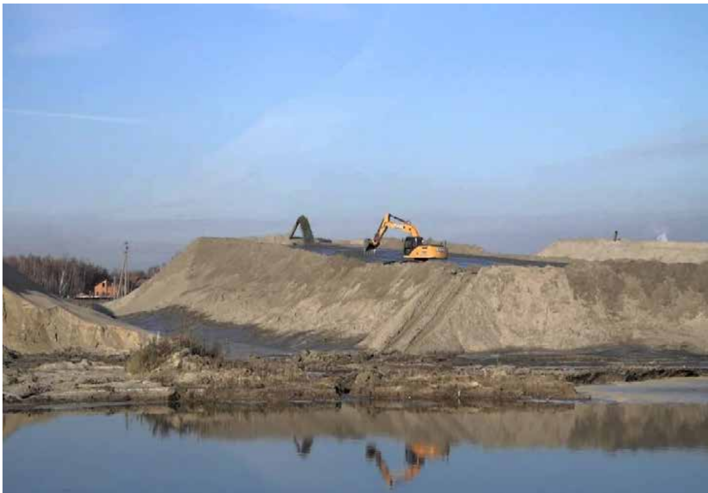
Рис. 1. Намыв штабеля песчаного грунта. На бортах откосов штабеля виден процесс инфильтрации технологической воды, при которой происходит вынос мелких частиц и возникают потери грунта \Pi_{\phi}
