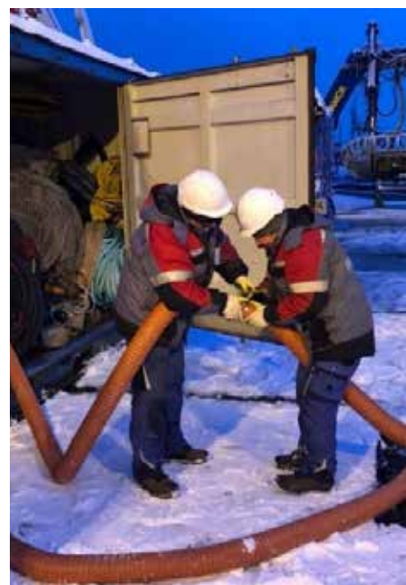
Рис. 4. Присоединение парового рукава
